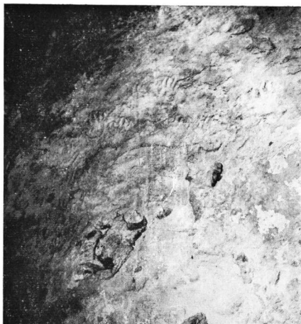
α. Χαρακτηριστικό κονίαμα με ίχνη από πόδια και χέρια στον τοίχο του γλιαρού χώρου.
