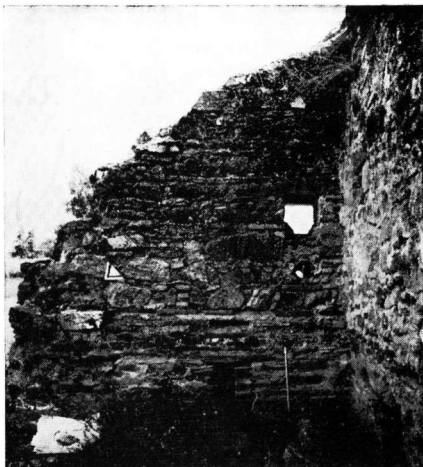
α. Ο χώρος τροφοδοσίας της εστίας. Αριστερά ίχνος του τοίχου που έκλεινε το χώρο (βέλος). Δεξιά ο τοίχος της εστίας με τον καπναγωγό.
