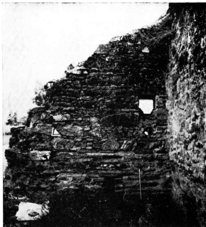
α. Ο χώρος τροφοδοσίας της εστίας. Αριστερά ίχνος του τοίχου που έκλεινε το χώρο (βέλος). Δεξιά ο τοίχος της εστίας με τον καπναγωγό.
