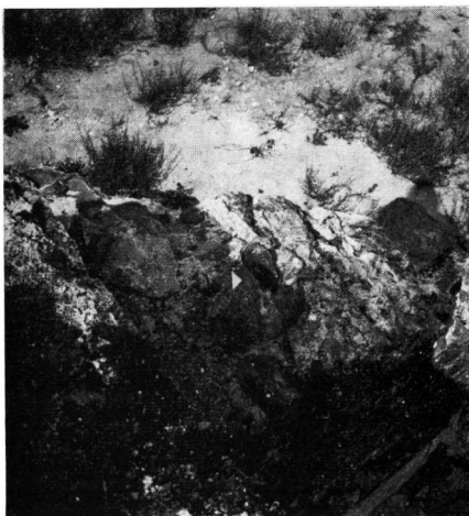
β. Δυτικός τοίχος του χώρου τροφοδοσίας. Βέλος στο στόμιο κάθετου κεραμικού αγωγού.
