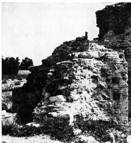
β. Η κατασκευή υδροδότησης (μικρή δεξαμενή-γεράνι-πηγάδι) στη β.δ. γωνία του δυτικού τοίχου του χώρου τροφοδοσίας (βέλος).
