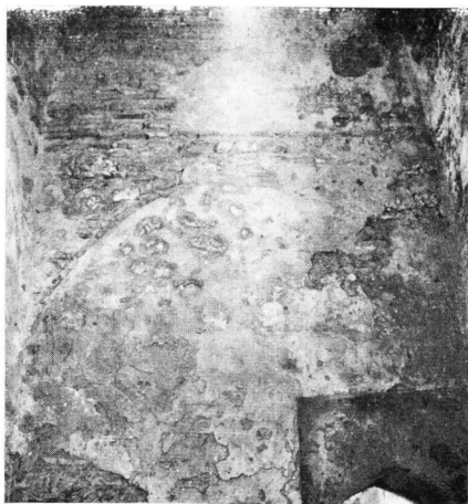
β. Ίχνος από τόξο στον ανατολικό τοίχο του γλιαρού χώρου και άνω μέρος εισόδου προς το χώρο υγιεινής. Το ίχνος του τόξου ενδεικτικό για τις φάσεις (2η, 3η) και την προϋπάρχουσα στέγαση.
