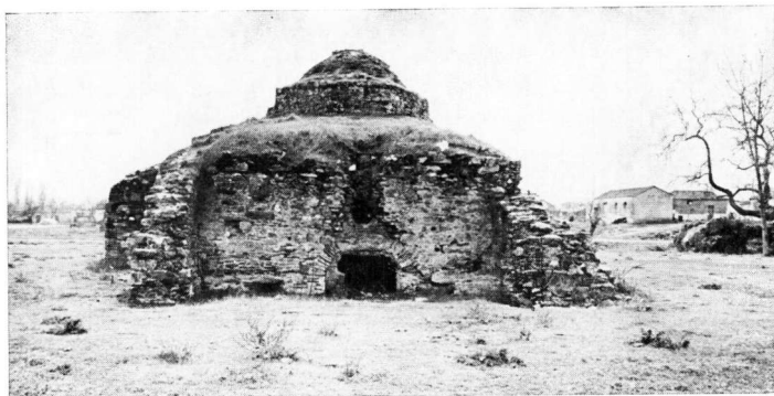
β. Η βόρεια πλευρά μετά τον καθαρισμό (αρχείο 9ης Ε.Β.Α.).
