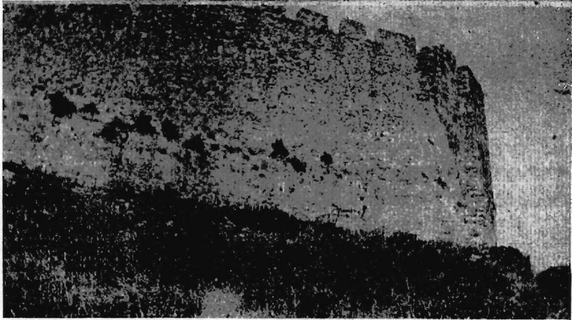
Εἰκ. 5. Τμῆμα τοῦ ἐξωτερικοῦ τείχους μὲ κατεύθυνση πρὸς Ν.
