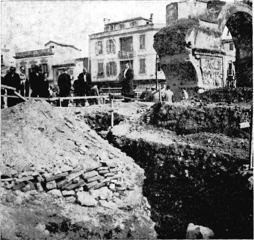
Εἰκ. 3. Ἀνασκαφὴ τῆς παρὰ τὴν Καμάραν αἰθούσης μετὰ τὸ ψηφιδωτὸν δάπεδον
