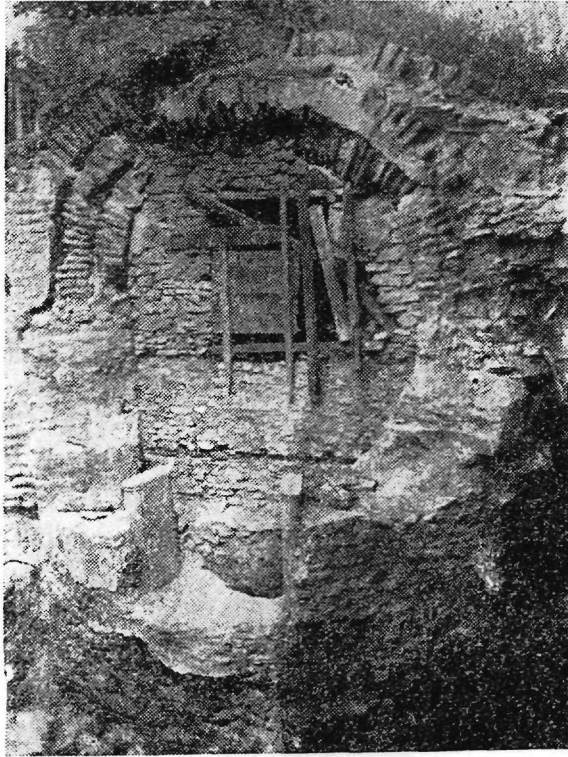
Εἰκ. 5. Ἡ κατάσταση τῆς ἀψίδος τοῦ Βαπτιστηρίου τῆς Ἀχειροποιήτου μετὰ τὴν ἀφαίρεσιν τῶν χωμάτων.
