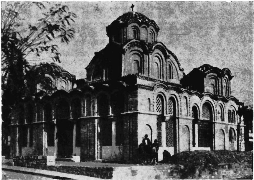
Ἡ βασιλικὴ τοῦ Ἁγ. Δημητρίου (ἄνω) καὶ ὁ ναὸς τῆς Ἁγ. Αἰκατερίνης (κάτω) μετὰ τὰς ἀναστηλωτικὰς ἐργασίας. (27, 39)
