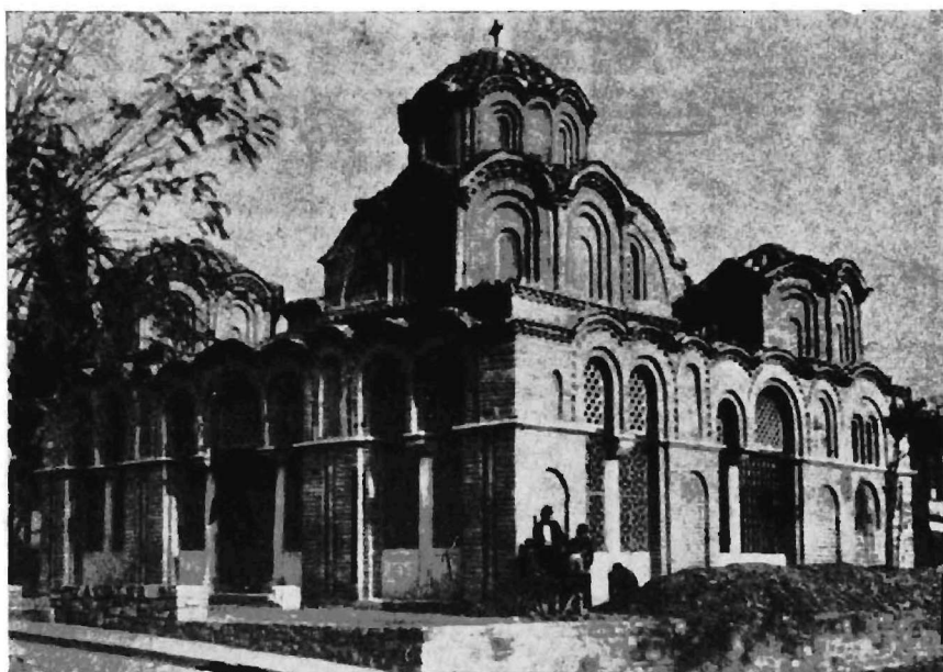
Ἡ βασιλικὴ τοῦ Ἁγ. Δημητρίου (ἄνω) καὶ ὁ ναὸς τῆς Ἁγ. Αἰκατερίνης (κάτω) μετὰ τὰς ἀναστηλωτικὰς ἐργασίας. (27, 39)
