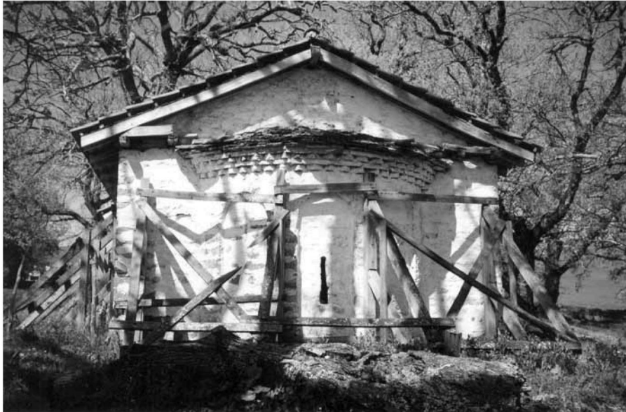
Εικ. 1. Άποψη της ανατολικής πλευράς του ναού. View of the east side of the church.
