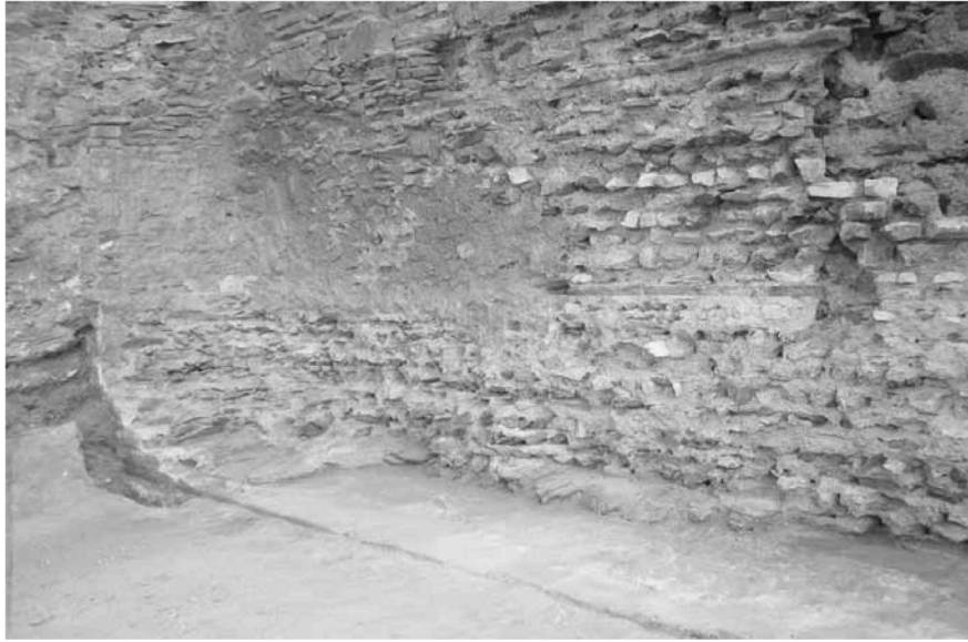
Εικ. 5. Λεπτομέρεια τοιχοδομίας του μεταπυργίου Π12-Π11. Ph. 5. La partie des remparts entre la tour no 12 et la tour no 11. Détail de la construction.
