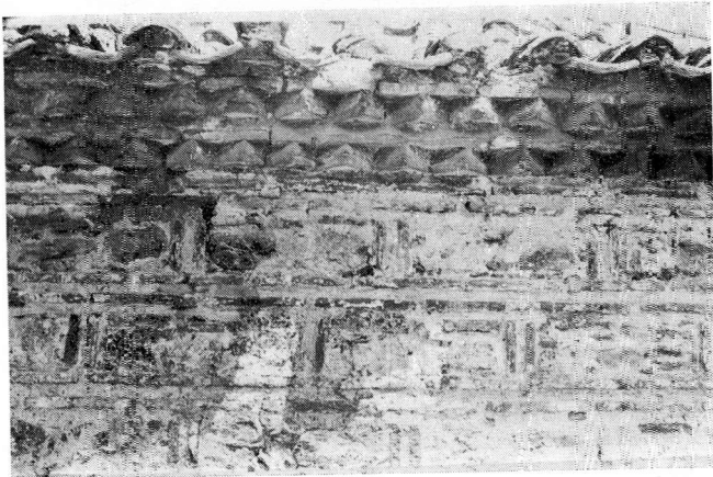
α. Τμήμα όψης με τρόπο δόμησης το βυζαντινό πλινθοπερίκλειστο
