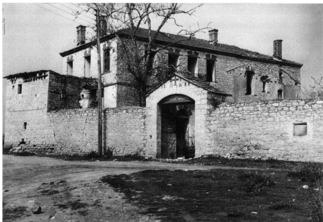
Είκ. 18. Άποψη από ΝΑ τοῦ μετοχιακοῦ συγκροτήματος τῆς Μ. Βατοπεδίου (φωτ. 1988).
