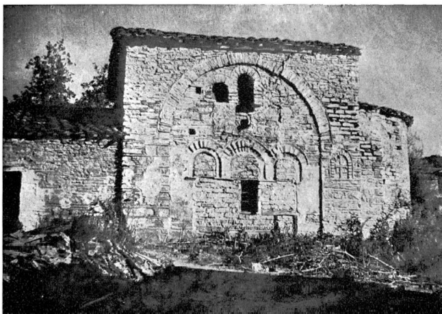
α. Ἀποψις νοτίας πλευρᾶς μετὰ τοῦ νάρθηκος
