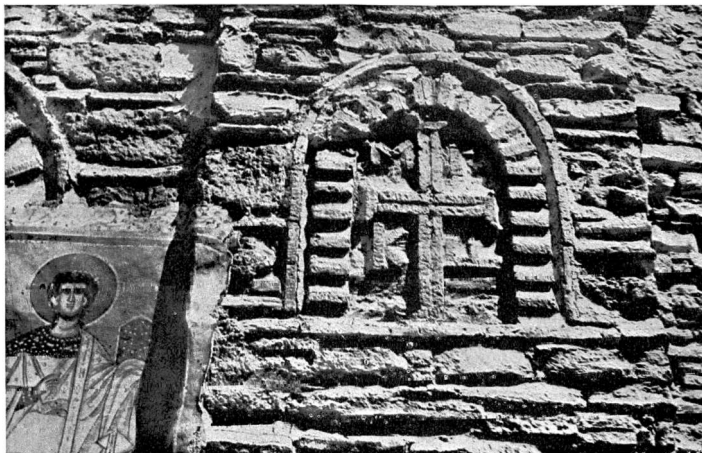
α. Τμήμα τῆς νοτίας πλευρᾶς
