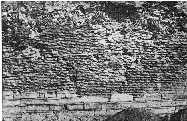
Εἰκ. 4. Τμήμα τοῦ εἰς τὴν ὁδὸν Εἰρήνης τείχους μετὰ ἀπλῶν τόξων καὶ ἐδράνων τοῦ Ἱπποδρόμου
