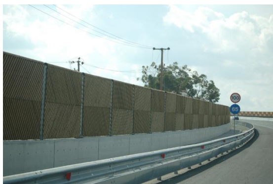
Εικόνα 6: Ξύλινο ηχοπέτασμα σε κάποιο δρόμο της Γερμανίας
