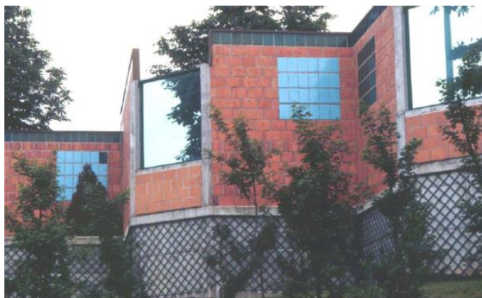
Εικόνα 2: Ηχοπέτασμα κατασκευασμένο από τούβλα με πολλές λεπτομέρειες σε αυτοκινητόδρομο κοντά σε αστική περιοχή του Παρισιού
