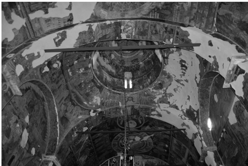
ΕΙΚΟΝΑ 6: Νέα Μονή Ζαλόγγου. Καθολικό. Άποψη του τρόπου στήριξης του τρούλου από τα δυτικά (Φωτογραφία Στ.Β. Μαμαλούκος, 2007)
