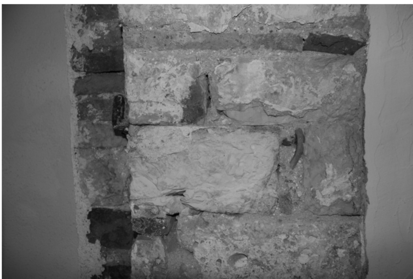
ΕΙΚΟΝΑ 25: Τμήμα τοιχοποιίας του μνημείου όπου διακρίνεται η ημιλαξευτή αργολιθοδομή. Στο κονιάμα είναι διακριτά μικρά κεραμικά στοιχεία και βότσαλα. Επίσης, έχουν γίνει μεταγενέστερες προσθήκες από σπτόπλινθους
