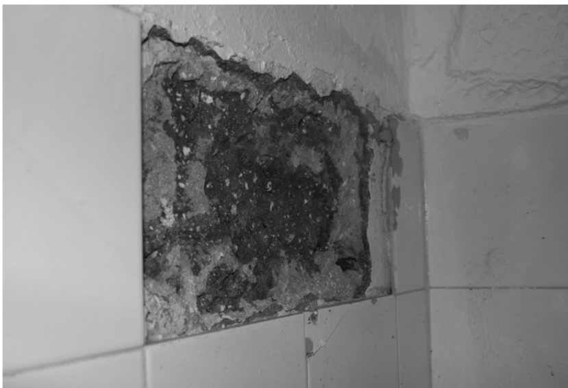
ΕΙΚΟΝΑ 24: Δοκιμαστική τομή στην τοιχοποιία του χώρου 1. Κάτω από το μεταγενέστερα τσιμεντοκονιάμα, εντοπίστηκε το κονιάμα επικάλυψης και κάτω από αυτό η αργολιθοδομή
