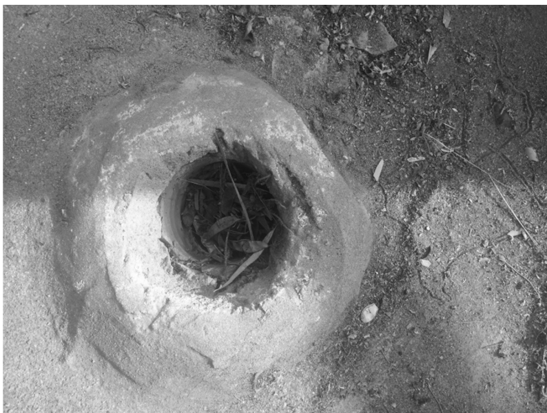
ΕΙΚΟΝΑ 20B: Άποψη αεραγωγού από τη στέγη
