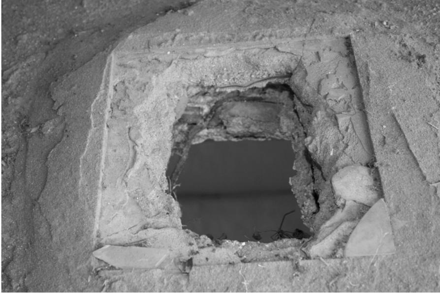
ΕΙΚΟΝΑ 26: Μετά την αποδόμηση των σύγχρονων τσιμεντοκονιών διακρίνεται η πлинθοδομή των θολωτών κατασκευών
