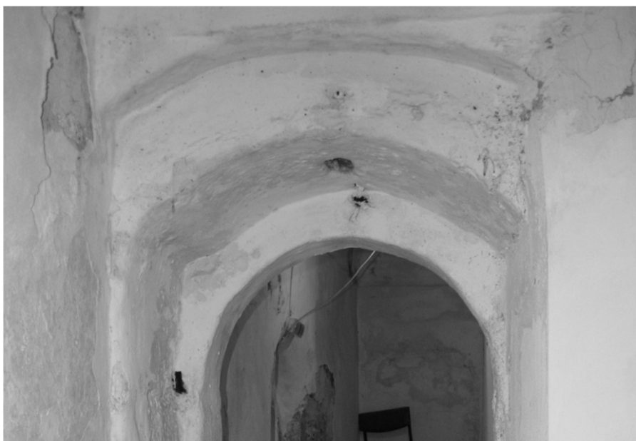
ΕΙΚΟΝΑ 20Α: Εντοιχισμένος αεραγωγός στο άνοιγμα της πόρτας
