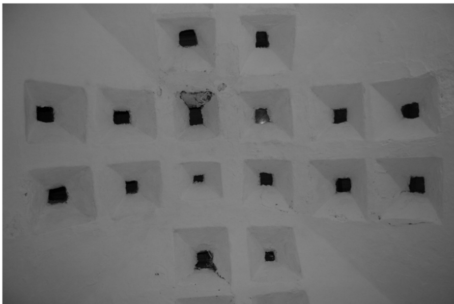
ΕΙΚΟΝΑ 19: Φωτιστικές θυρίδες, άποψη από εσωτερικά του θόλου
