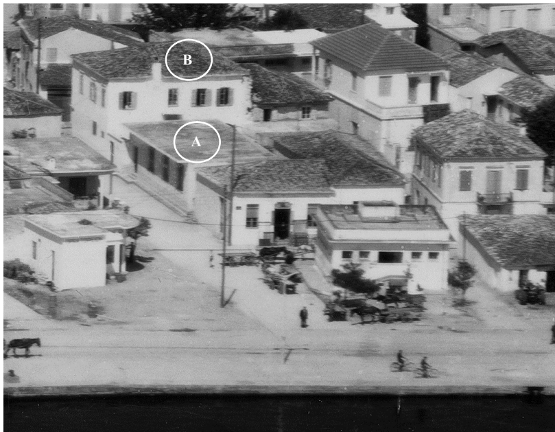
ΕΙΚΟΝΑ 13: Η Αίθουσα Πνευματικής Εστίας «Ο Άγιος Δημήτριος» (Α) και το κτήριο που στέγαζε το Οικοτροφείο της Μητροπόλεως (Β). Λεπτομέρεια αεροφωτογραφίας, 22.5.1963 (Φωτογραφικό αρχείο Ιδρύματος Ακτία Νικόπολις)
