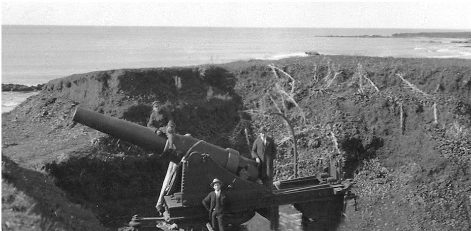
ΕΙΚΟΝΑ 12: Το πυροβόλο Κρούπ στο πυροβολείο «Χαμηδιέ». Το πυροβολείο ήταν γνωστό και με το όνομα «Καλκ-Μπαμπά». Φωτογραφία του 1925 περίπου (Ίδρυμα Ακτία Νικόπολις F2827)
