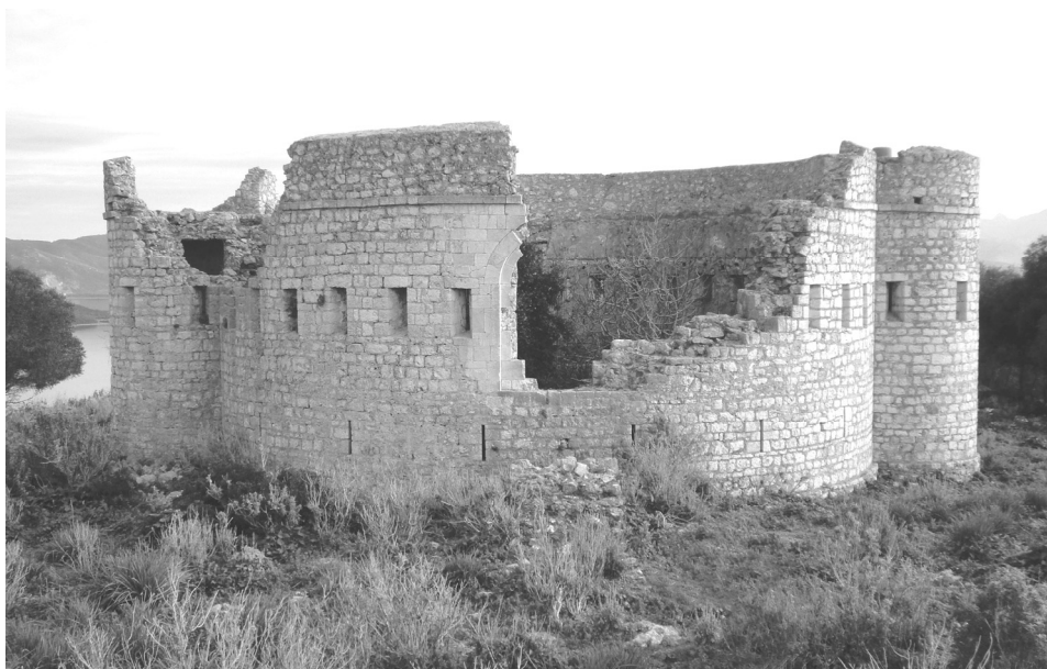
ΕΙΚΟΝΑ 14: Η «κούλια της Λασκάρας» που βομβαρδίστηκε το 1897. Όψη από τη βόρεια πλευρά της, όπου και η πύλη εισόδου (Φωτογραφία Νίκου Δ. Καράμπελα, 2010)
