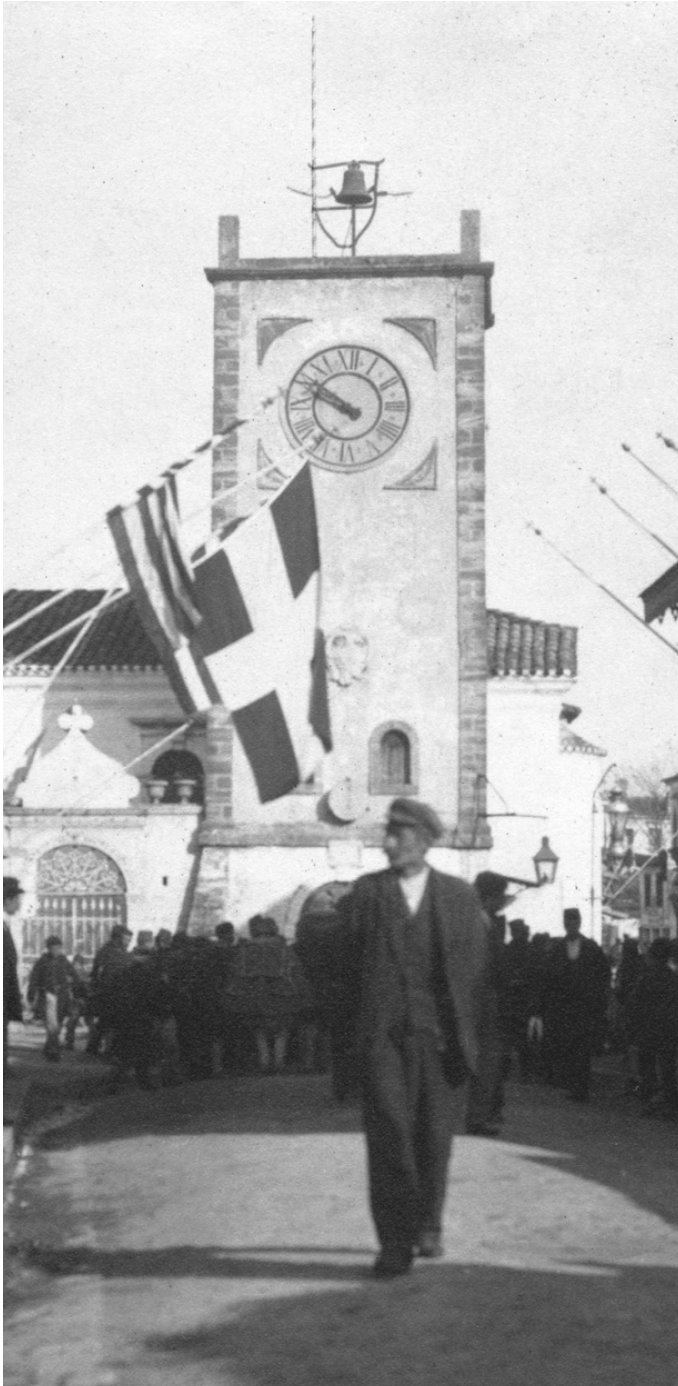
ΕΙΚΟΝΑ 22: Ο ενετικός πύργος του ρολογιού της Πρέβεζας που κτίστηκε το 1792. Λεπτομέρεια φωτο- γραφίας Etienne Labranche (Ίδρυμα Ακτία Νικόπολις F2285)
