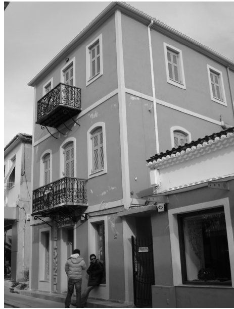
ΕΙΚΟΝΑ 11: Αστική κατοικία που αποκαταστάθηκε (Αρχείο Ε. Σαρρή, 2008)
