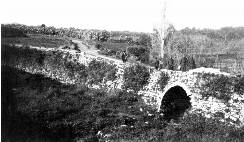
ΕΙΚΟΝΑ 34: Τμήμα της περιφερειακής τάφρου της Πρέβεζας στη θέση Φόρος. Η τάπια ήταν τότε επενδεδυμένη εσωτερικά με πέτρα. Το ποτάμι Καρυδάς πέραγε εγκάρσια στην τάπια, κάτω από τοξωτό άνοιγμα. Φωτογραφία του Etienne Labranche του 1913 (Φωτογραφικό αρχείο Ιδρύματος Ακτία Νικόπολις)
