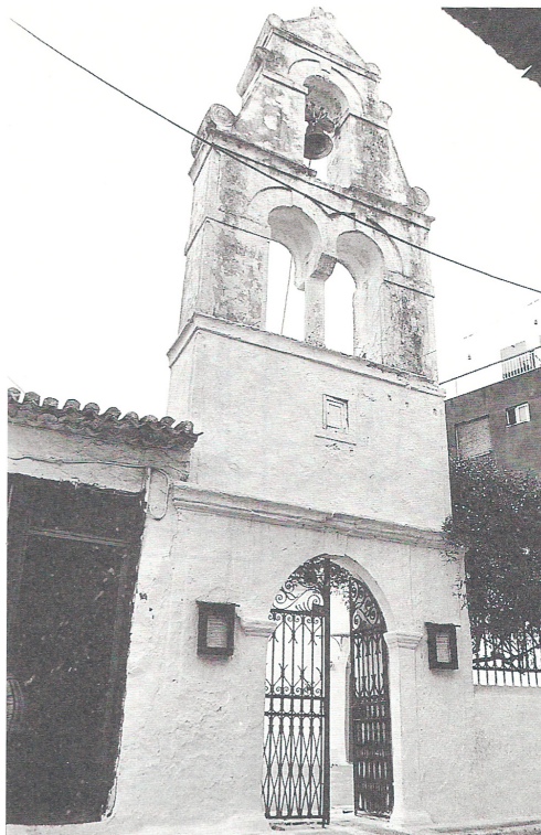
ΕΙΚΟΝΑ 3: Το κωδωνοστάσιο του ναού του Αγίου Αθανασίου στην Πρέβεζα (Φωτογραφία Σταύρου Μαμαλούκου)
