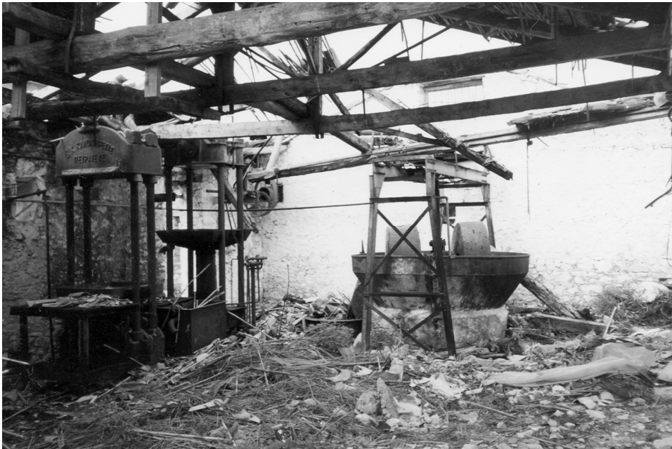
Εικόνα 18: Ελαιοτριβείο Νεοχωρίου. Άποψη του εσωτερικού προς τα βορειοανατολικά
