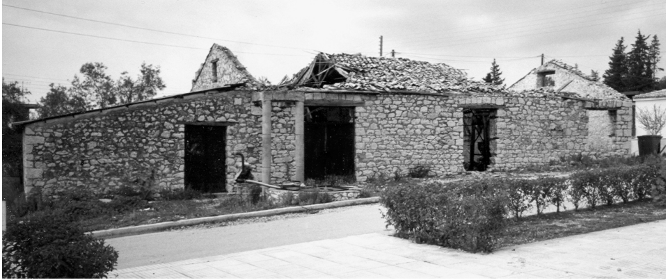
ΕΙΚΟΝΑ 17: Ελαιοτριβείο Νεοχωρίου. Άποψη από τα νοτιοδυτικά
