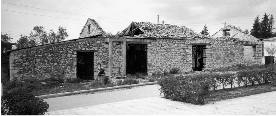
ΕΙΚΟΝΑ 17: Ελαιοτριβείο Νεοχωρίου. Άποψη από τα νοτιοδυτικά
