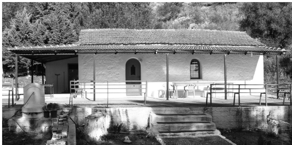
ΕΙΚΟΝΑ 14. Ο ναός αγίας Παρασκευής Σκάλας Λούρου μετά την ανύψωση της νότιας εισόδου του ναού. (Φωτογραφία Ν.Δ.Κ. Σεπτέμβριος 2007)
