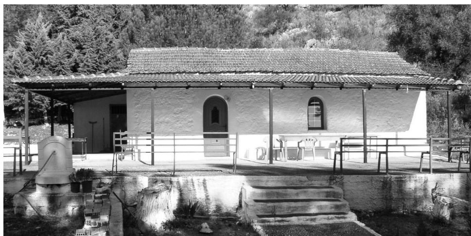
ΕΙΚΟΝΑ 14. Ο ναός αγίας Παρασκευής Σκάλας Λούρου μετά την ανύψωση της νότιας εισόδου του ναού. (Φωτογραφία Ν.Δ.Κ. Σεπτέμβριος 2007)
