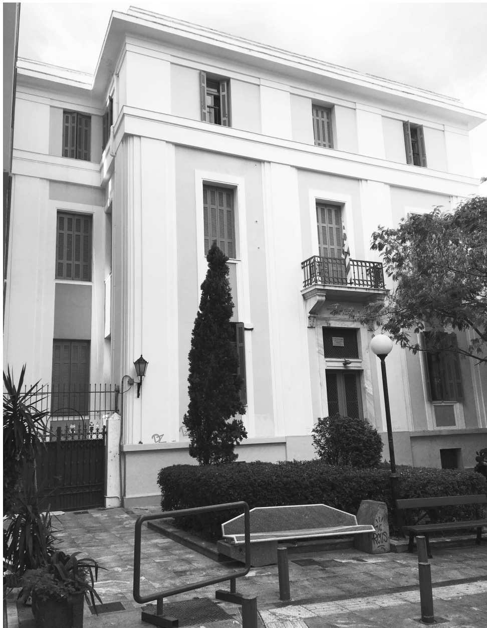
ΕΙΚΟΝΑ 2: Η οικία Πέτρου Ηπίτη στην Πλάκα, Αθήνα. Από το 1993 στεγάζει το 1ο Πειραματικό Λύκειο Αθηνών – Γεννάδειο, προς τιμήν του πρώτου του γυμνασιάρχη, Γ. Γενναδίου. (Φωτογραφία Σπύρου Σουμαλεύρη)
