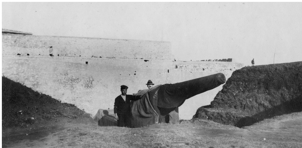
ΕΙΚΟΝΑ 16: Το τοπομαχικό Κρουπ επί του τριγωνικού ΝΔ προμαχώνα του κάστρου. Πίσω το κυρίως οχυρό. Εκατέρωθεν του τοπομαχικού, χωμάτινα προστατευτικά αναχώματα.
