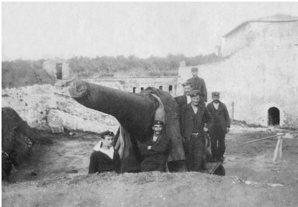
ΕΙΚΟΝΑ 19: Το τοπομαχικό Κρουπ επί του τριγωνικού ΝΔ προμαχώνα του κάστρου. Πίσω δεξιά το κυρίως πεντάγωνο οχυρό. Φωτογραφία του Καλλιγά του 1913. (ΚΑΡΑΜΠΕΛΑΣ 2002, 32)
