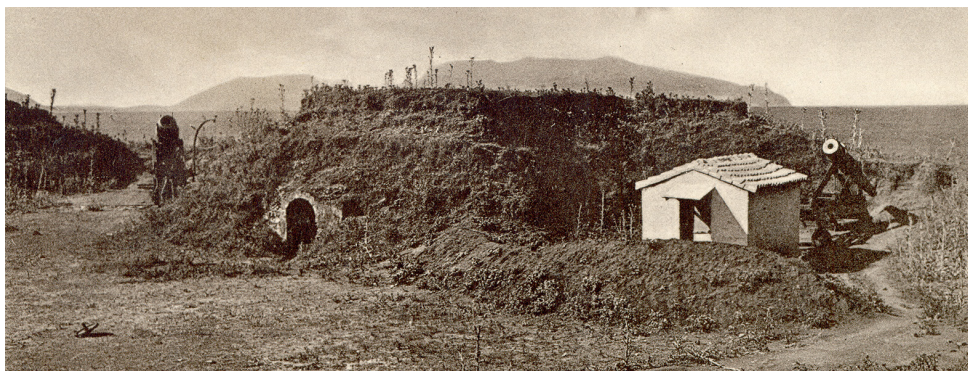
ΕΙΚΟΝΑ 20: Το πυροβολείο «Καλκ Μπαμπά», βορειοδυτικά του κάστρου του Παντοκράτορα. Οψη προς τα νότια. Στο βάθος το νησί της Λευκάδας. Διακρίνονται τα δύο τοπομαχικά πυροβόλα, νεότερο φυλάκιο, και ένα από τα δύο χωμάτινα αναχώματα, που χρησίμευαν και ως αποθήκες, πιθανότατα πυρομαχικών.
