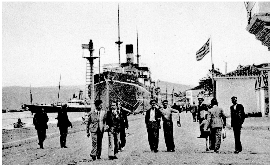
ΕΙΚΟΝΑ 9: Το λιμάνι της Πρέβεζας προπολεμικά, με τον φάρο στο κέντρο και τα κτήρια του Λιμεναρχείου και της Εθνικής Τράπεζας στα δεξιά, περ. 1936. (Φωτογραφικό αρχείο Ιδρύματος Ακτία Νικόπολις, Πρέβεζα. IAN F1238)
