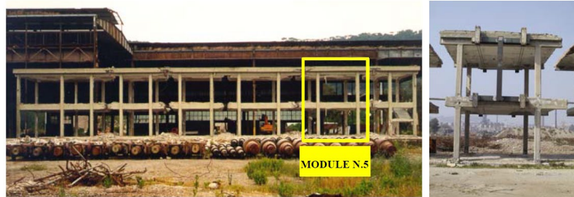
Fig. 5. General view of the module n.5.
