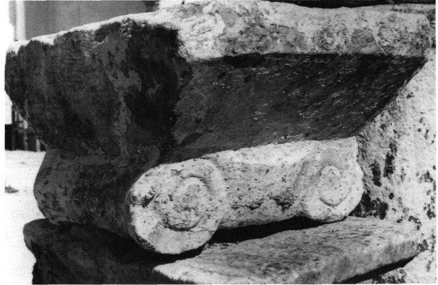
Εικ. 4. Μονή Ζωοδόχου Πηγῆς. "Ιωνικό κιονόκρανο μέ ἐπίθημα, ἑνός ἀπό τούς κίονες του κυρίως ναοῦ.
