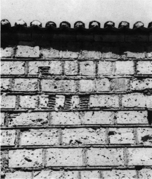
Εικ. 7. Μονή Ζωοδόχου Πηγής. Δύο ειδών τοιχοποιίες στην νοτιά πλευρά του πυλώνος.
