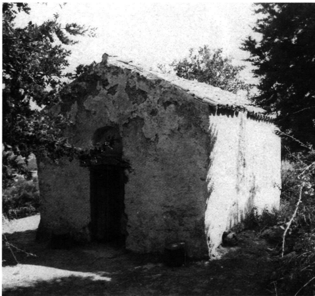
Εικ. 1. "Αποψη του ναού της Ἁγίας Μαρίας στὸν Μορνέ ἀπὸ νοτιοδυτικά.
